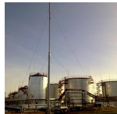
Свеча рассеивания для сброса газо- и паронефтепродуктов высотой 35 м.
